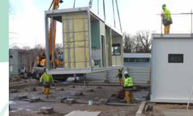
Assemblage des modules
